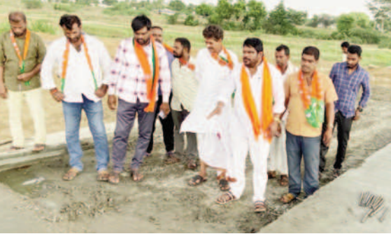
కాజీవే నిర్మాణ పనులను పరిశీలిస్తున్న
